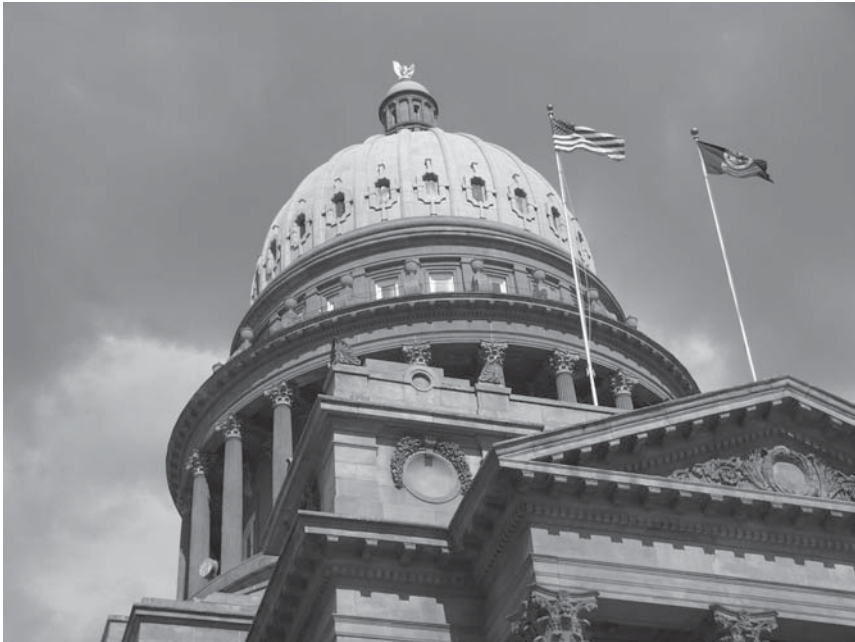
Capitol Dome Exterior
