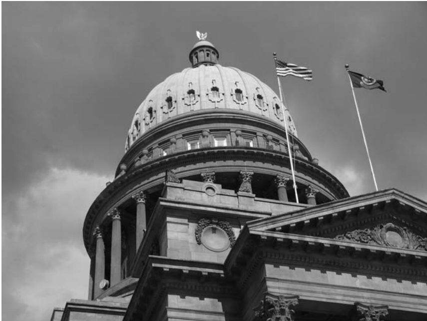
Capitol Dome Exterior
